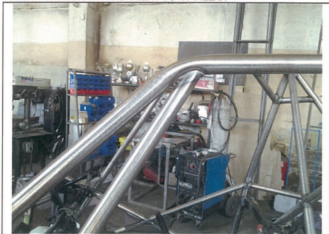
PHOTO 7 МЕСТО СОЕДИНЕНИЯ ПЕРЕДНЕЙ ДУГИ СО СТОЙКОЙ «А» FRONT ROLLBAR ATTACHMENT TO "A" PILLAR
